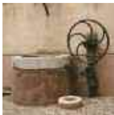
La 'manxa' de la calle de Can Pintat es de planta circular y dispone de una rueda de hierro.
